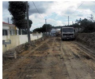
7 - Rua Casal do Pinhão, Bairro Senhora da Luz: Obras de rebaixamento do piso e substituição do colector de esgoto.
