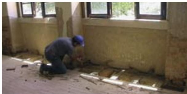
2 - Os pavimentos existentes foram substituídos
