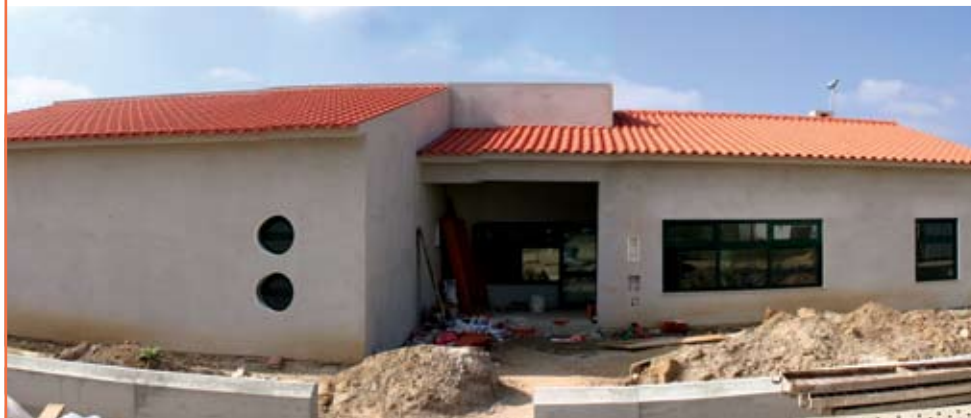
AMOREIRA Está em fase de conclusão os trabalhos de construção do Jardim-de-Infância
