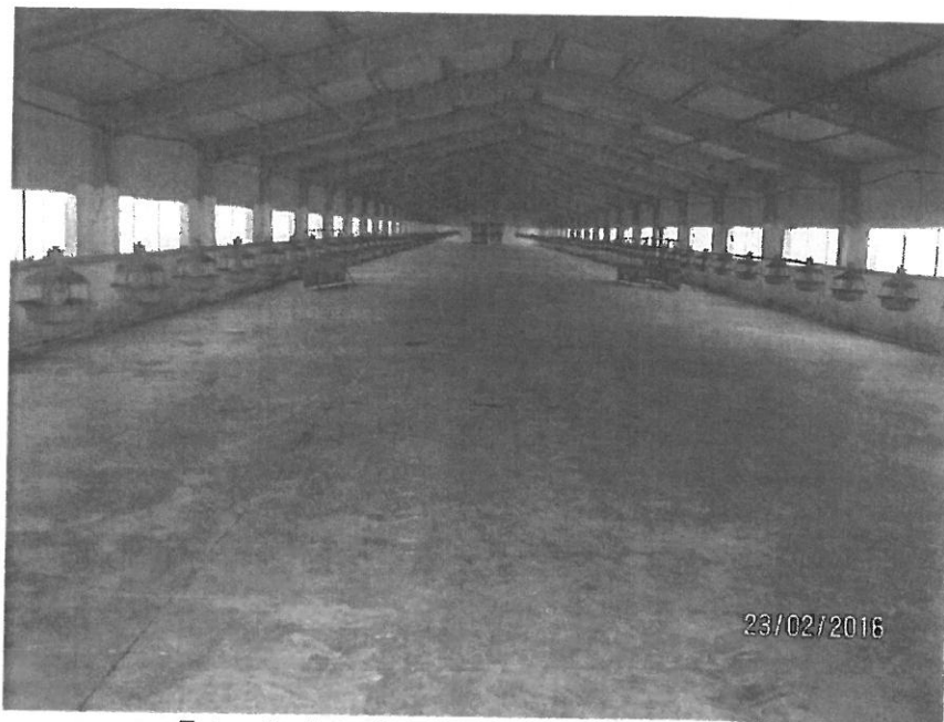
Foto_9: Interior Pavilhão 3 desinfetado
