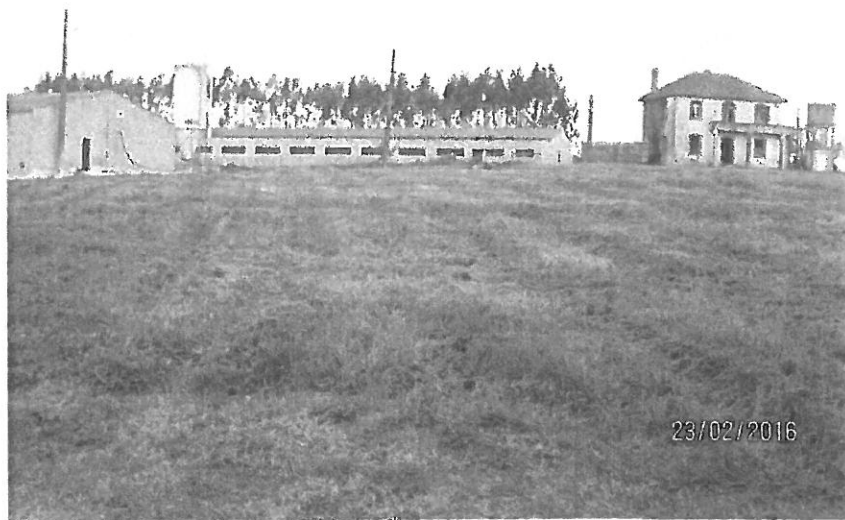
Foto_19: Vista Geral Pavilhão 14
