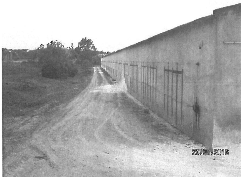
Foto_3: Vista Lateral Pavilhão 6
